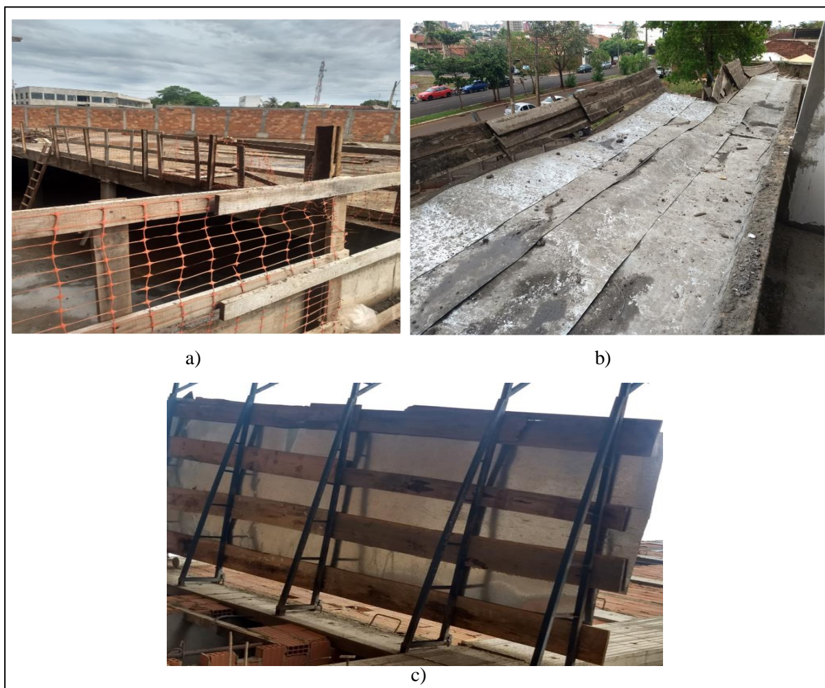
Figura 05 – Guarda-corpos e bandeja mista em estados não preservados e apoio para bandeja em distância irregular
