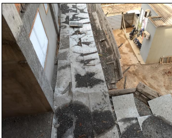
Figura 07 – Bandejas do tipo zinco Fonte: Acervo fotográfico registrado pela autora (2019).
