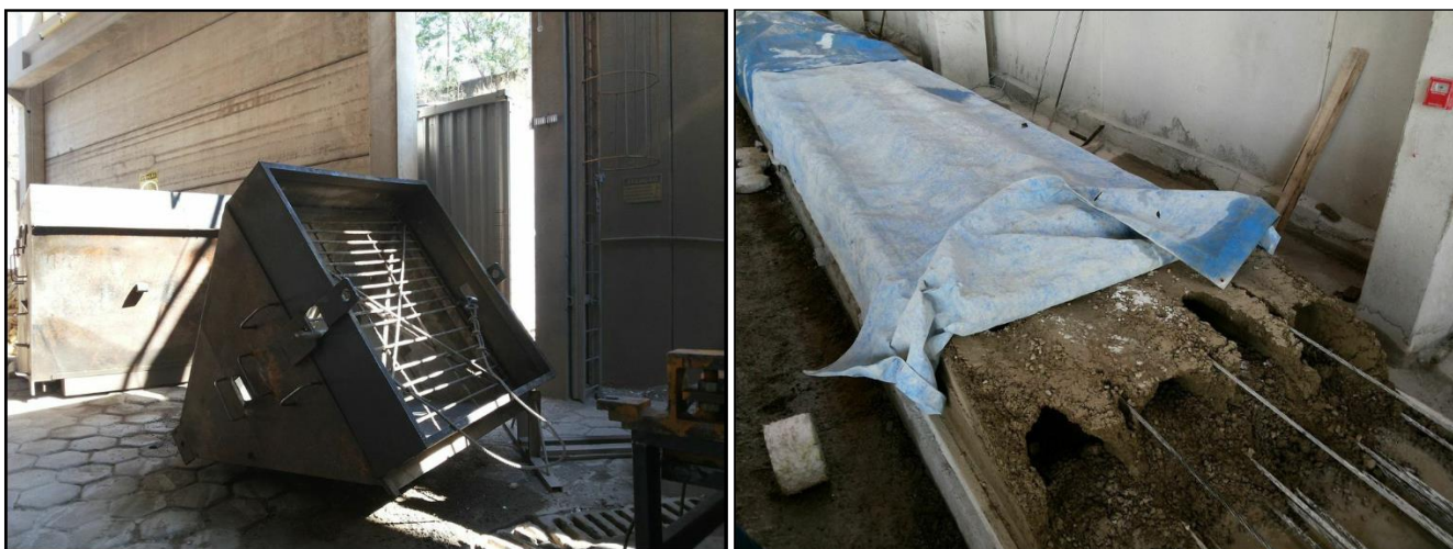
Figuras 10 e 11: Equipamento para lançamento do concreto e laje em processo de cura.
