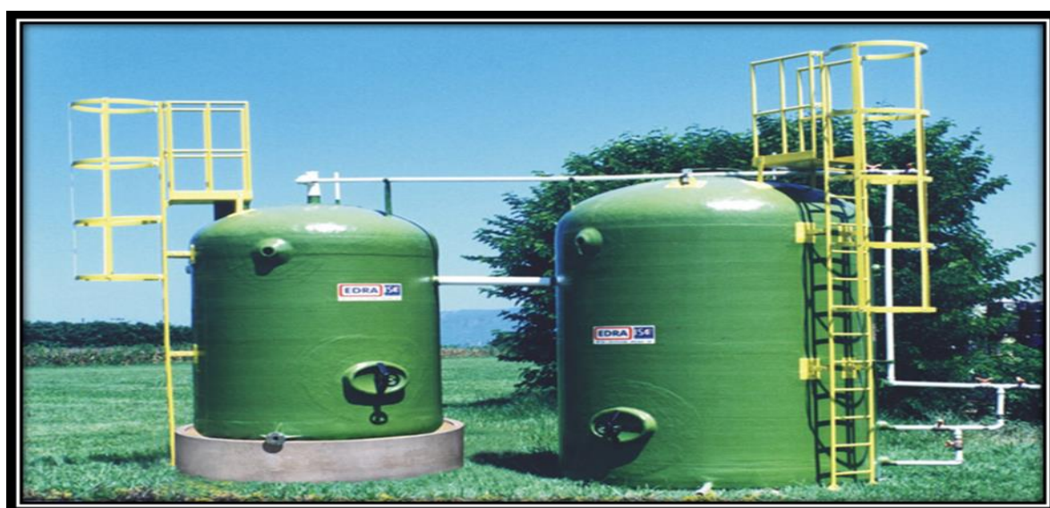
FIGURA 01 - Estação de tratamento de efluentes compacta.
