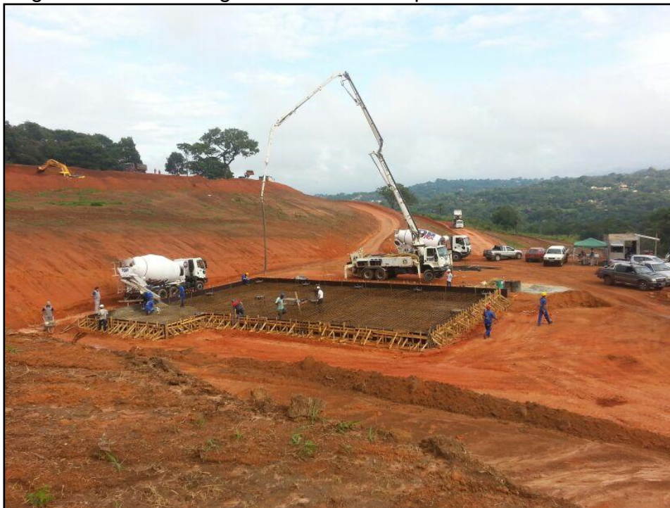
Figura 17 - Concretagem do radier estaqueado da torre 1 da UTM
