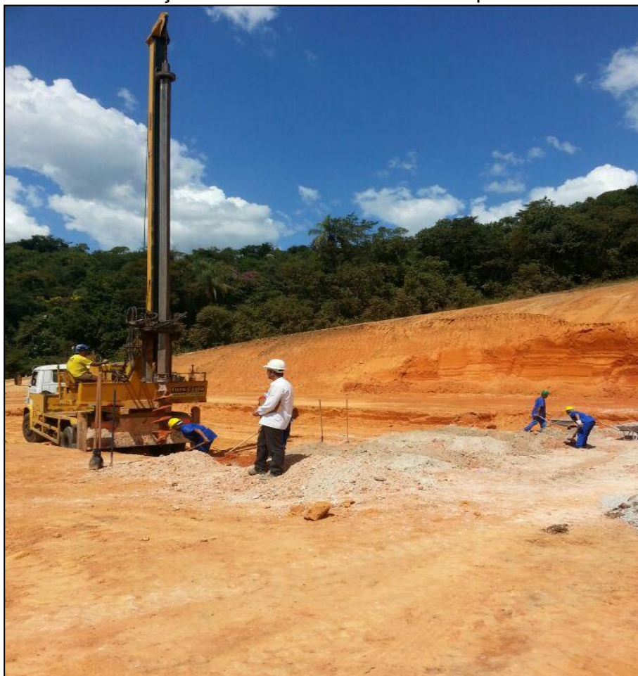
Figura 14 - Escavação das estacas do radier estaqueado da torre 1 da UTM.
