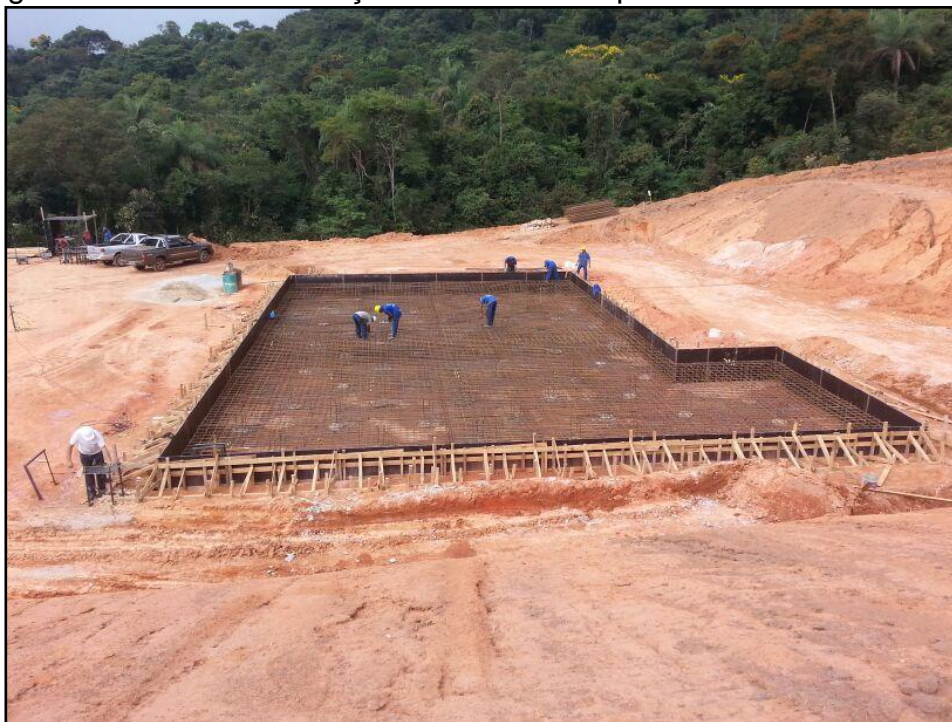
Figura 15 - Forma e Armação do radier estaqueado da torre 1 da UTM.
