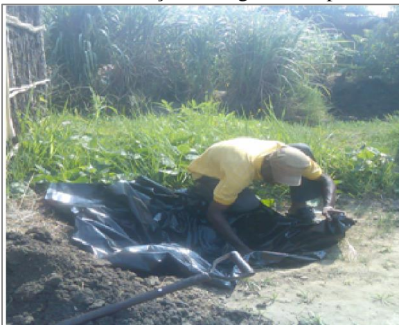
2º Passo: Betumação do esgoto com plastico
