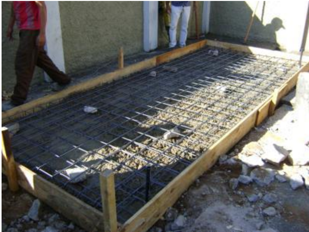
Figura 45 – Infra para instalação do armário que abrigará os equipamentos Fonte: Autores.
