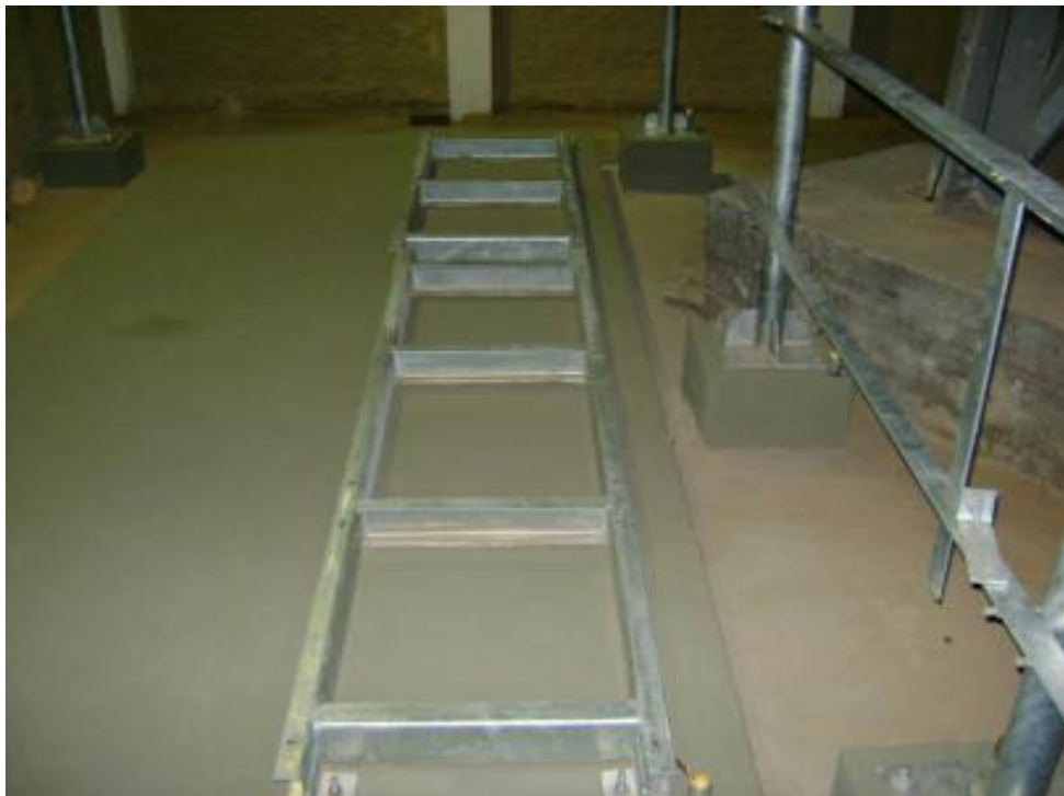
Figura 46 – Infra para instalação do armário que abrigará os equipamentos Fonte: Autores.
